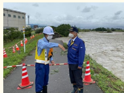
松本市梓川の堤防の被害現場を視察
