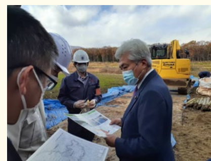
セシウム汚染稲藁移管工事現場にて(栃木県)
